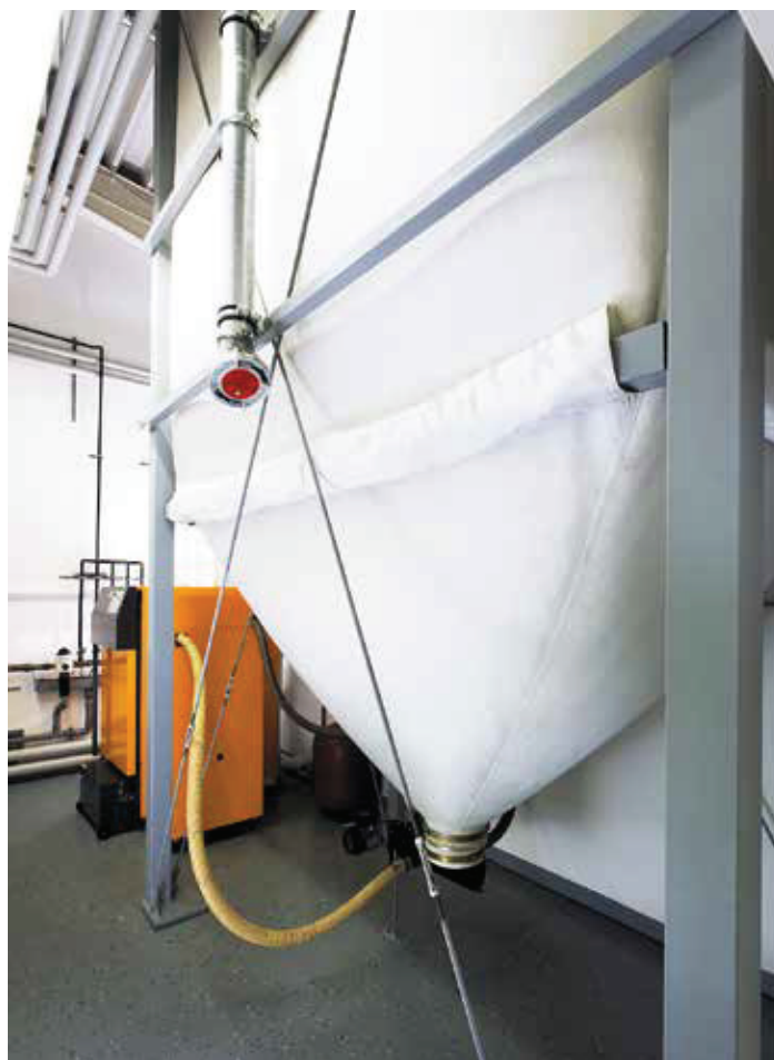
Gewebesilos sind in vielen Größen und Formen erhältlich. Bild: A. B. S.
